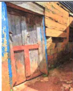
Foto1: El salón de cuarto primaria, actualmente tiene una puerta de madera, como se puede observar se encuentra en malas condiciones por lo que requiere cambio por una de metal.
