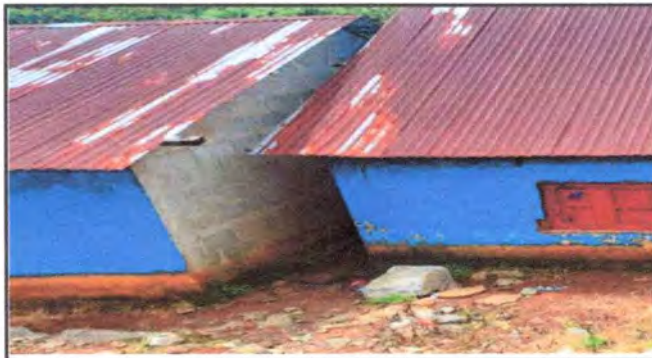
Foto 4: El salón de sexto primaria, tambien requiere cambio en la cubierta de lamina, en su mayoria se encuentran picadas dando lugar a las filtraciones de agua.
