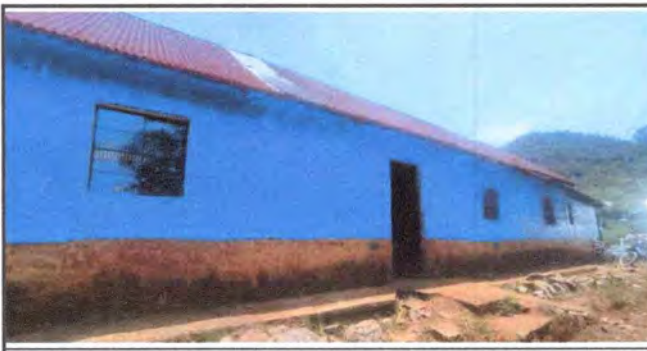
Foto 5: Las ventanas del tercero primaria, no cuentan con las medidas requeridas para brindar iluminación, por tal razón necesitan ampliación de las mimas.
