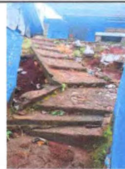
Foto 6: Las gradas que actualmente se utilizan, no presentan las condiciones adecuadas, ya que no cuentan con los pedales que normalmente se utilizan.
