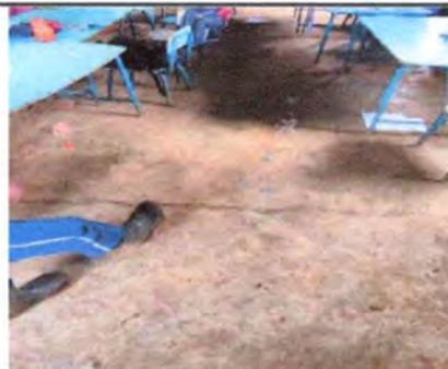
Foto 6: Otros ángulos del entortado de cemento ya deteriorado del salón de tercero primaria.
