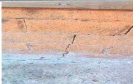
Foto 5: Evidencia del entortado del piso del modulo de tercero y cuarto. Requiere cambio por las malas condiciones en el que se encuentra.
