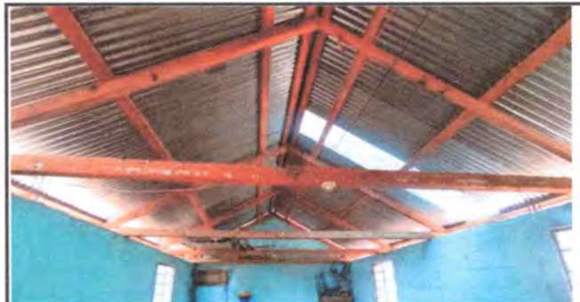
Foto 6: La estructura de la costanera del aula de sexto primaria, requiere cambio total por las condiciones deterioradas en las que se encuentran.
