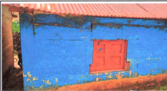
Foto 3: El salon de 4° primaria, actualmente cuenta con ventanas de madera, se encuentran con polilla y en estado deteriorado.
