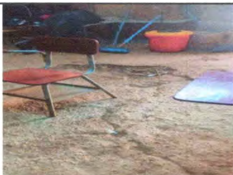
Foto 3: El entortado que actualente tienen los salones de tercero y cuarto primaria, en el módulo I requiere cambio total, ya que se encuentra quebrado en su mayor parte.
