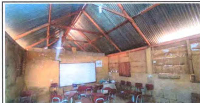
Foto 5: El módulo II que comprende las aulas de tercero y cuarto necesita cambio total de las costaneras, todas se encuentran con polilla y en estado deteriorado.
