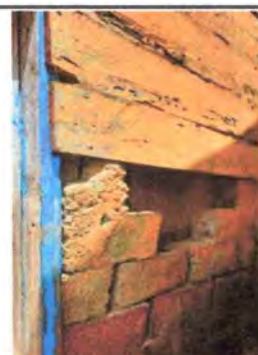
Foto 4: Evidencia de las hileras de block junto con el complemento de madera, que lleva mas de treinta años desde que fue su construcción. Representa un peligro para los educandos porque la estructura se mueve
