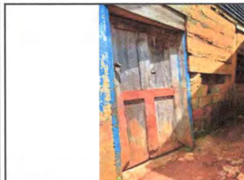
Foto 3: El salon de 4° primaria, necesita cambio total de toda su estructura física, actualmente cuenta con cinco hileras de bloc, y el complemento de madera. El block se encuentra agrietado en los cuatro lados del salón.
