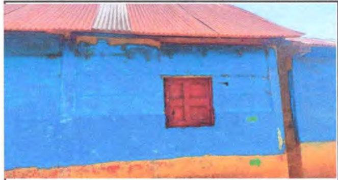
Foto 4: Esta parte, enfoca la ventana de madera del otro extremo. Se puede observar el estado en que se encuentra, las tablas con agujeros y bastante polilla.
