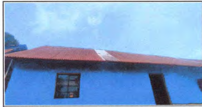
Foto 6: Evidencia de las ventas con medidas pequeñas, que dificultan la iluminación dentro del salón de clases de tercero primaria.
