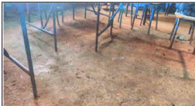
Foto 4: Evidencia del entortado de cemento del salón de tercero primaria.
